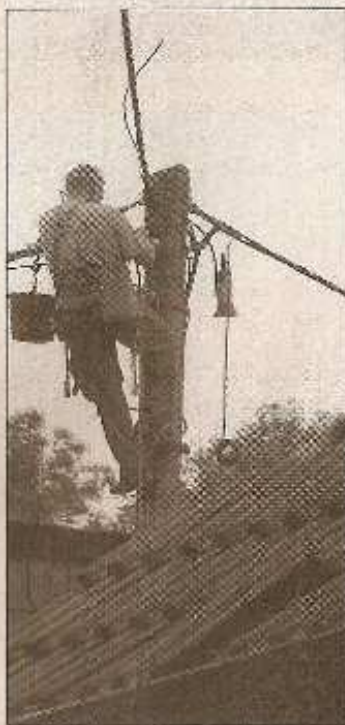
Ein Mitarbeiter des Versorgers repariert die Stromleitung.
