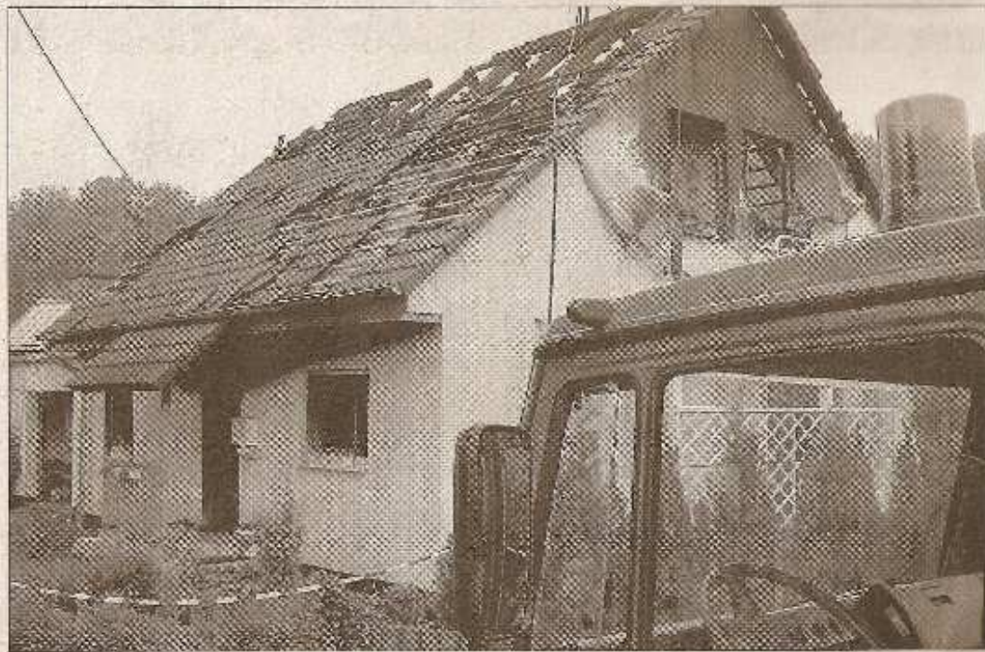
Am Morgen nach dem Brand steht fest: Das Einfamilienhaus in der Niederbreitbacher Weihergasse ist nicht mehr bewohnbar. Der Schaden für die Betroffenen ist immens. ■ Fotos: Ralf Grün
